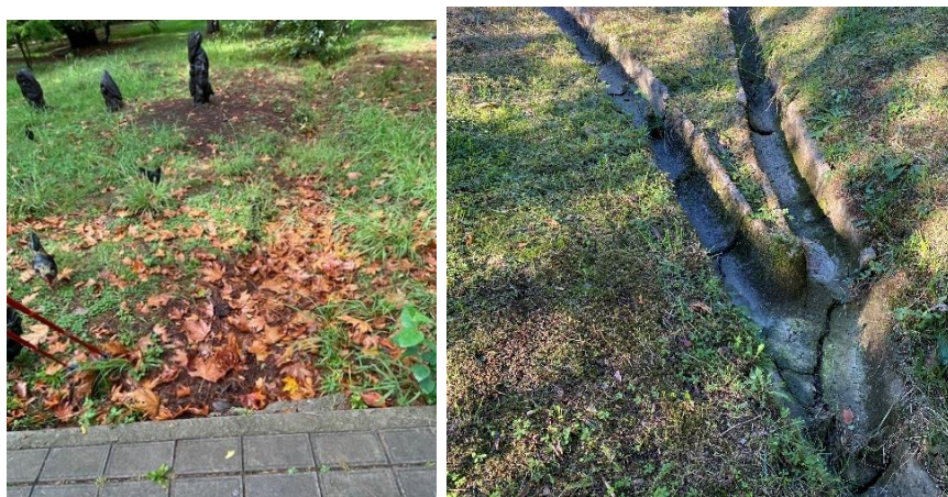
Рис. 5. Забитые мусором дренажи: слева – в Нижнем парке, справа – в Верхнем парке.
